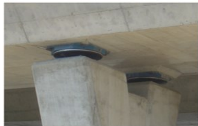
Σχήμα 13.22: Εφέδρανα ολίσθησης (FPS) εγκατεστημένα στην κορυφή των υποστυλωμάτων στήριξης του καταστρώματος γέφυρας του αυτοκινητοδρόμου έξω από τη Λεμεσό.
