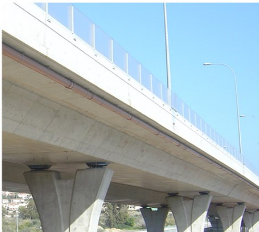
Σχήμα 13.22: Εφέδρανα ολίσθησης (FPS) εγκατεστημένα στην κορυφή των υποστυλωμάτων στήριξης του καταστρώματος γέφυρας του αυτοκινητοδρόμου έξω από τη Λεμεσό.
