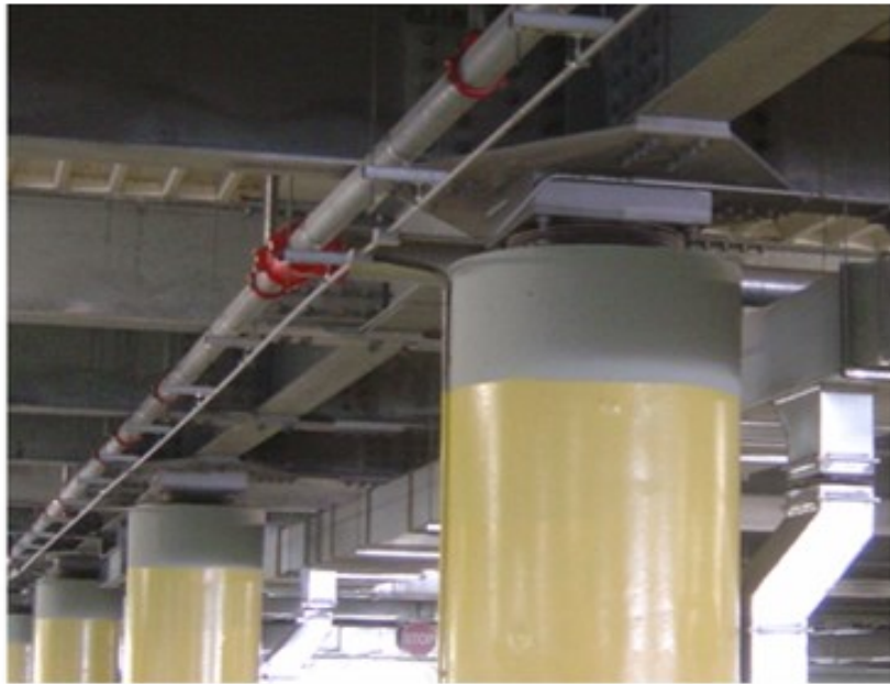
Σχήμα 13.24: Ελαστομερικά εφέδρανα υψηλής απόσβεσης (HDRBs) εγκατεστημένα στις κορυφές των υποστυλωμάτων του υπόγειου χώρου στάθμευσης του “The Mall of Cyprus” στη Λευκωσία.
