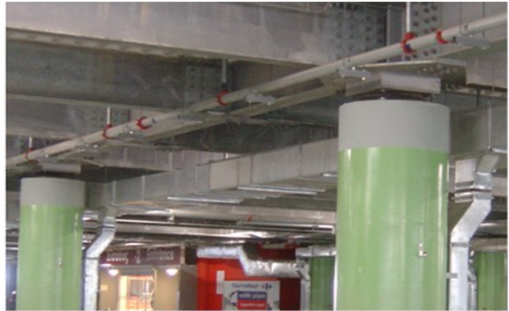
Σχήμα 13.24: Ελαστομερικά εφέδρανα υψηλής απόσβεσης (HDRBs) εγκατεστημένα στις κορυφές των υποστυλωμάτων του υπόγειου χώρου στάθμευσης του “The Mall of Cyprus” στη Λευκωσία.
