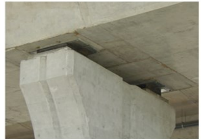
Σχήμα 13.23: Ελαστομερικά εφέδρανα με διπλούς πυρήνες μολύβδου εγκατεστημένα στην κορυφή των υποστυλωμάτων στήριξης του καταστρώματος γέφυρας του αυτοκινητοδρόμου έξω από τη Λεμεσό.
