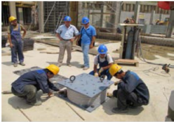
Εγκατάσταση ελαστομερικών εφεδράνων με πυρήνα μολύβδου στη θεμελίωση του Russian International Olympic University (Smirnov et al., 2011).
