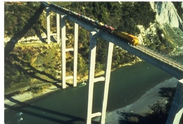
Σιδηροδρομική γέφυρα νότιου Rangitikei, Νέα Ζηλανδία
