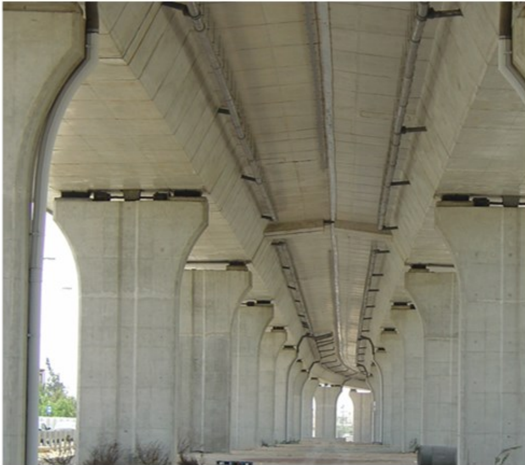
Σχήμα 13.23: Ελαστομερικά εφέδρανα με διπλούς πυρήνες μολύβδου εγκατεστημένα στην κορυφή των υποστυλωμάτων στήριξης του καταστρώματος γέφυρας του αυτοκινητοδρόμου έξω από τη Λεμεσό.
